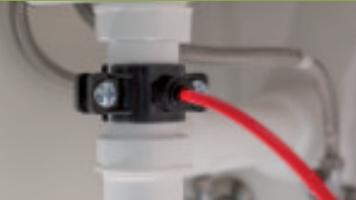
Rotes 1/4" Rohr für das Abwasser am Siphon - max. 2 m
