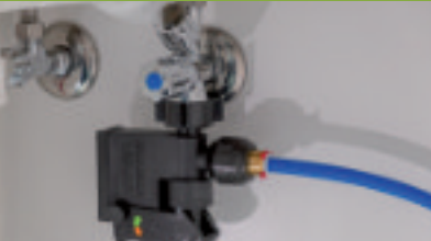
Blaues 3/8" Rohr für die Wasserzufuhr am Eckventil
